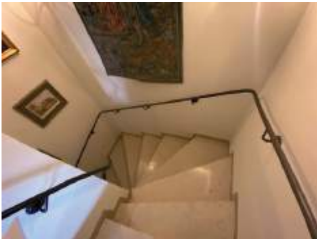
Durchgehender Handlauf Treppe
